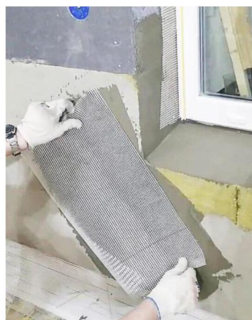
Рис. 26. Установка «косынок» на внешние углы проемов.
