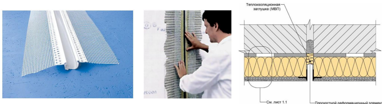
Рис. 28. Установка плоскостного деформационного элемента.
