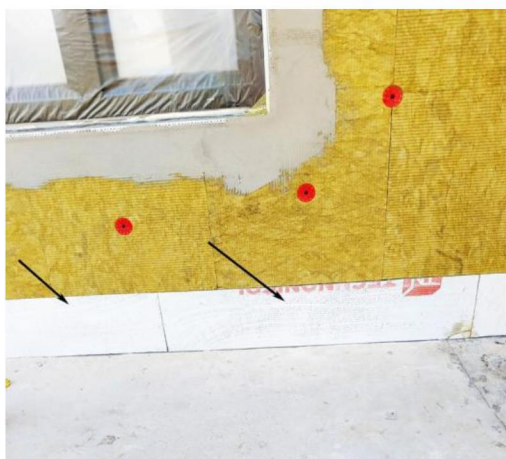
Рис. 19. Примыкание фасадного утеплителя заподлицо к утепляемому цоколю. Стрелками показан экструдированный пенополистирол
