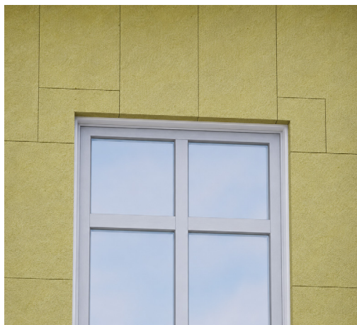
Рис. 22. «Сапожки» вокруг углов оконных откосов.
